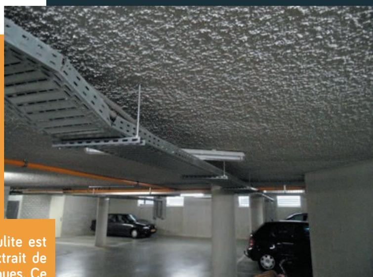
d'utilisation. Sa principale fonction est de protéger : une fois mélangé au mortier en « protection passive incendie » il garantit que les structures des bâtiments et constructions tiennent encore pendant 4 heures en cas d'incendie (> 1000 ° C). Avec
